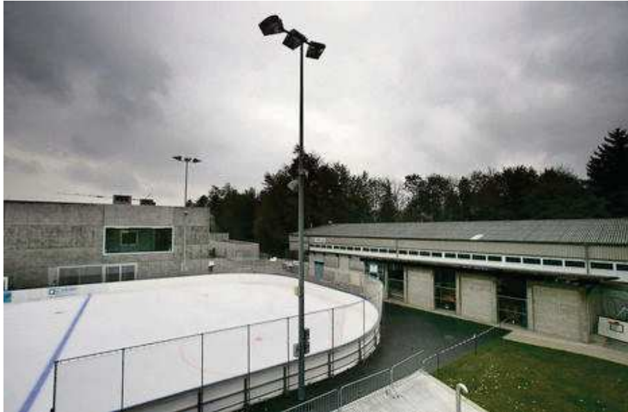
Teilen künftig ihre Infrastruktur: Die Eishalle (links) und die neue Curlinghalle, die an Stelle der jetzigen (rechts) gebaut wird. Bild: Michel Canonica
